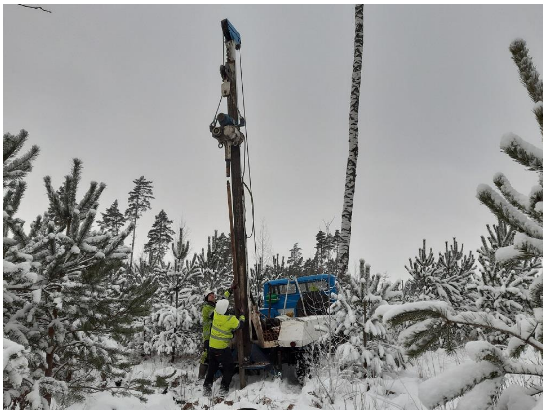
Foto 4.1. Vibropuurimine puurpingiga ABБ-2M (PA 10 uuringuruumi idaosas) (foto T. Tuuling, 27.12.2021, N 58°44'15" ja E 24°60'35").
